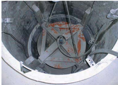
Ofenzustellung mit NKH
