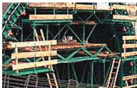
Oszalowanie tunelu
