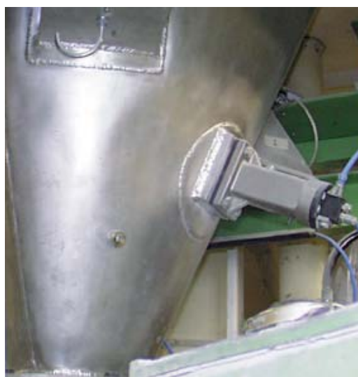
Czyszczenie ścianki zbiornika
