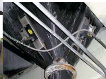
Prévention de la formation de ponts à l'aide de vibrateurs pneumatiques circulaires
