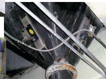
Usuwanie nawisów za pomocą wibratorów pneumatycznych o kołowej charakterystyce drgań
