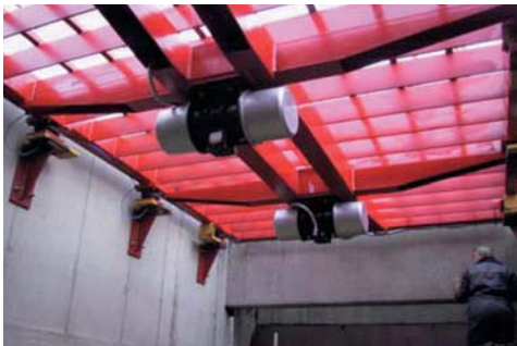
Sieben von grobem Schüttgut mit Elektro-Außenvibratoren
